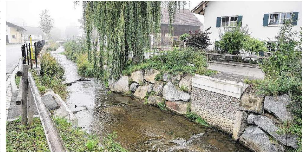
Das Foto zeigt die Stelle an der Gennach, wo seit mehreren Jahren eine Brücke fehlt, weil diese abgebaut werden musste. An zwei anderen Orten im Dorf ist die Situation ähnlich. Foto: Karlheinz Stumbaum (Archivbild)
